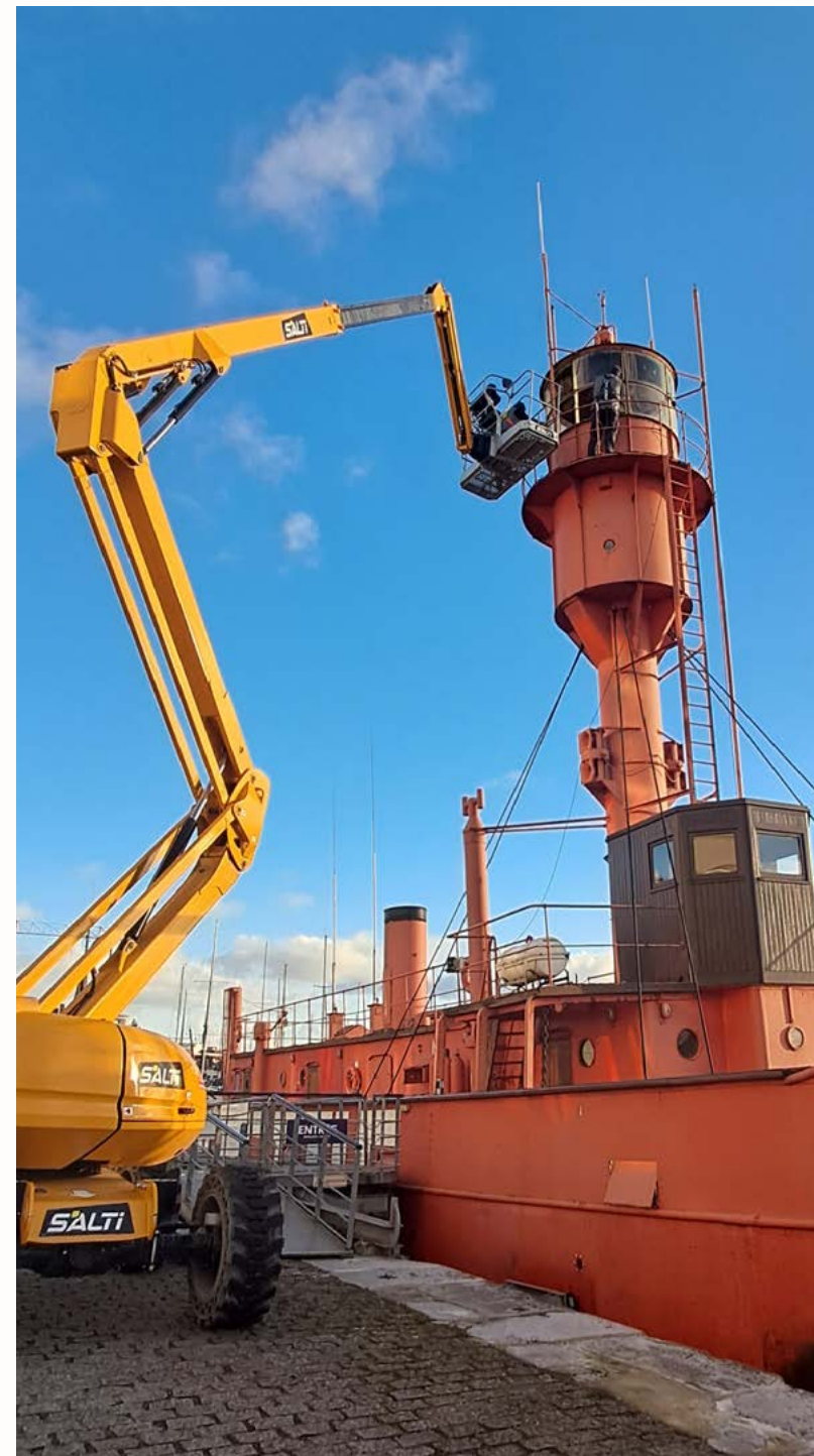
Installation de verre bombé en rénovation
