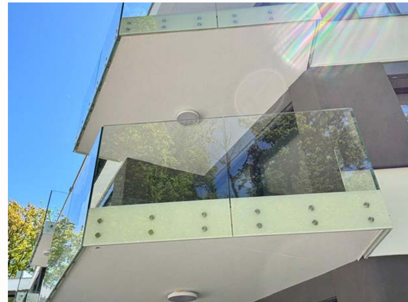
Intégration de matière sur mesure entre deux verres feuilletés, intégration de pièces techniques dans le verre pour fixation
