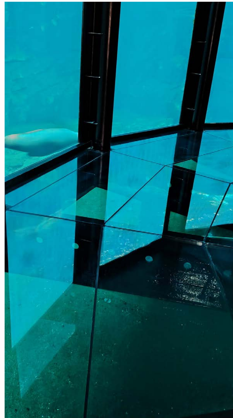
Plancher en verres feuilletés trempés au-dessus d'un bassin aquatique
